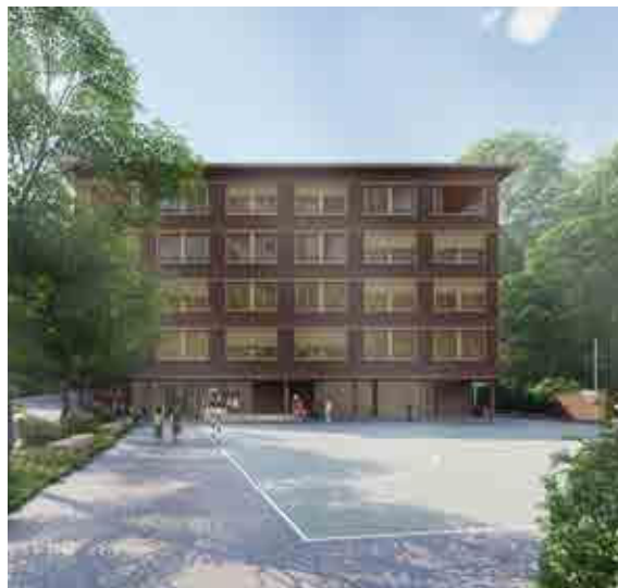
Unaufgeregt und selbstverständlich setzt sich der kompakte, schlichte Neubau an die Waldkante und bildet einen starken Rücken für die Schul- und Sportfreiräume.
