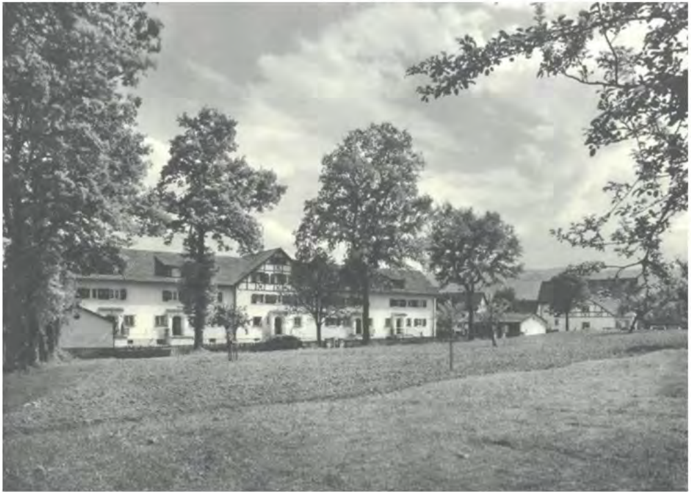
Historische Fotografie des Bahnhöfli, Siedlung Ober Emmenweid, um 1942
