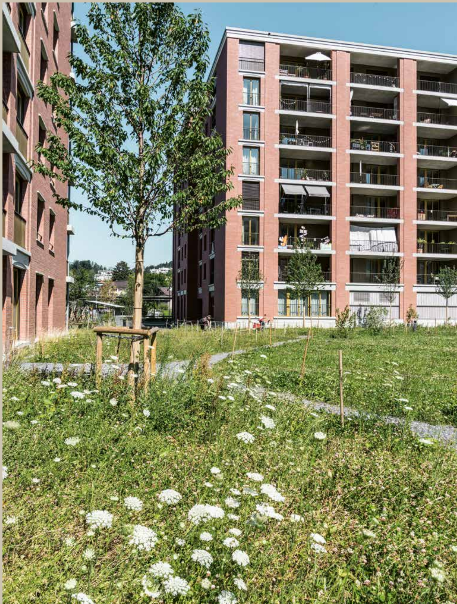
1 Das Areal Ziegeleipark wurde vom Freiraum her entwickelt: Erste Bauetappe war der öffentliche Park, der die verschiedenen Baufelder miteinander verbindet. Le site Ziegeleipark a été développé à partir des espaces extérieurs: la première étape a été le parc public, qui relie les différentes zones bâties. L'area Ziegeleipark è stata sviluppata a partire dagli spazi aperti: la prima tappa è stata la realizzazione del parco pubblico, che collega le diverse zone edificabili. FOTOS: DANIELA VALENTINI; SKIZZEN: STUDIO VULKAN LANDSCHAFTSARCHITEKTUR
