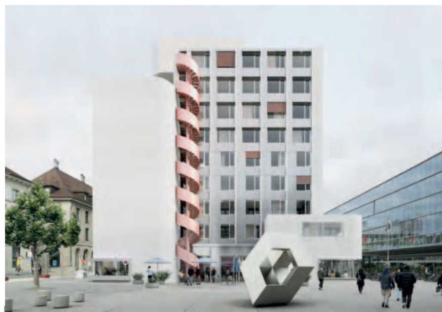
Die fein gegliederte Fassade stärkt die Gebäudeskulptur und betont ihre markante, dynamische Präsenz.
