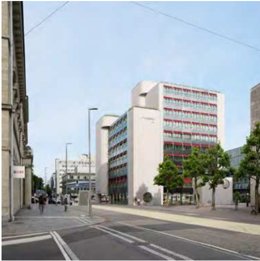
Bahnhofstrasse von Westen
