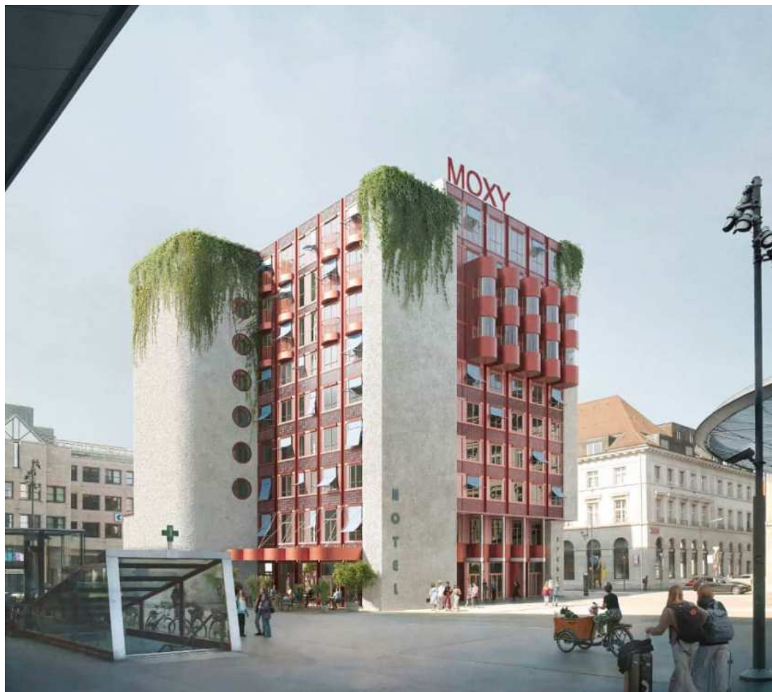
Transformation Hotel Aarauhof | BHSF Architekten
