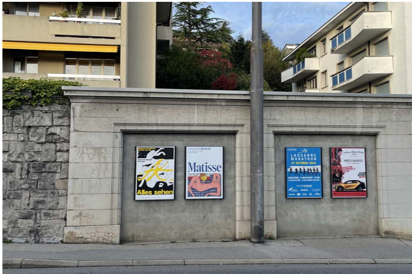
Rue du Simplon continuité du mur de soutènement
