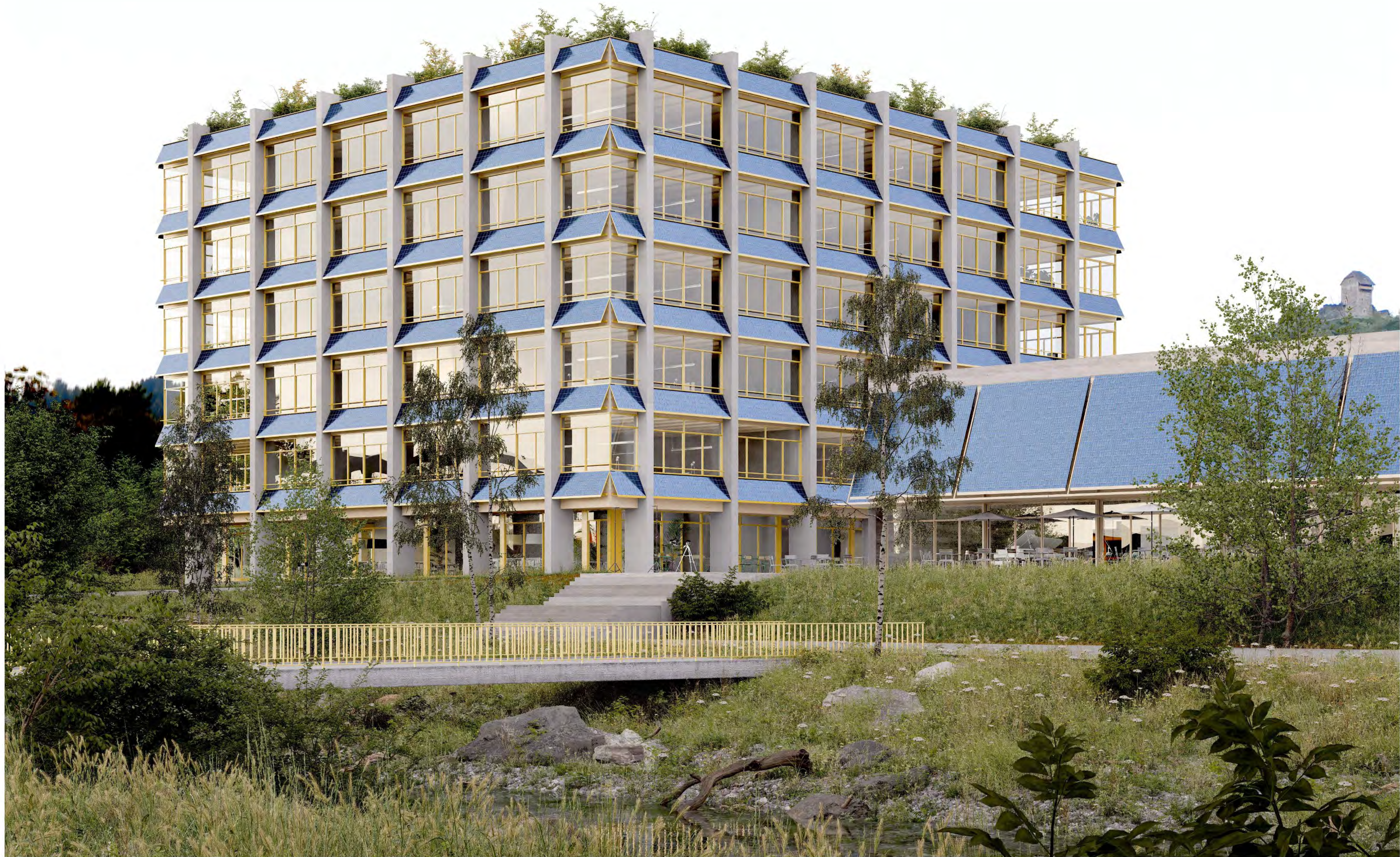
Die bestehende ungenutzte Turnhalle wird zum pulsierenden Zentrum des Campus und schafft mit dem multifunktionalen Raum und der Cafeteria einen lebendigen Treffpunkt.
