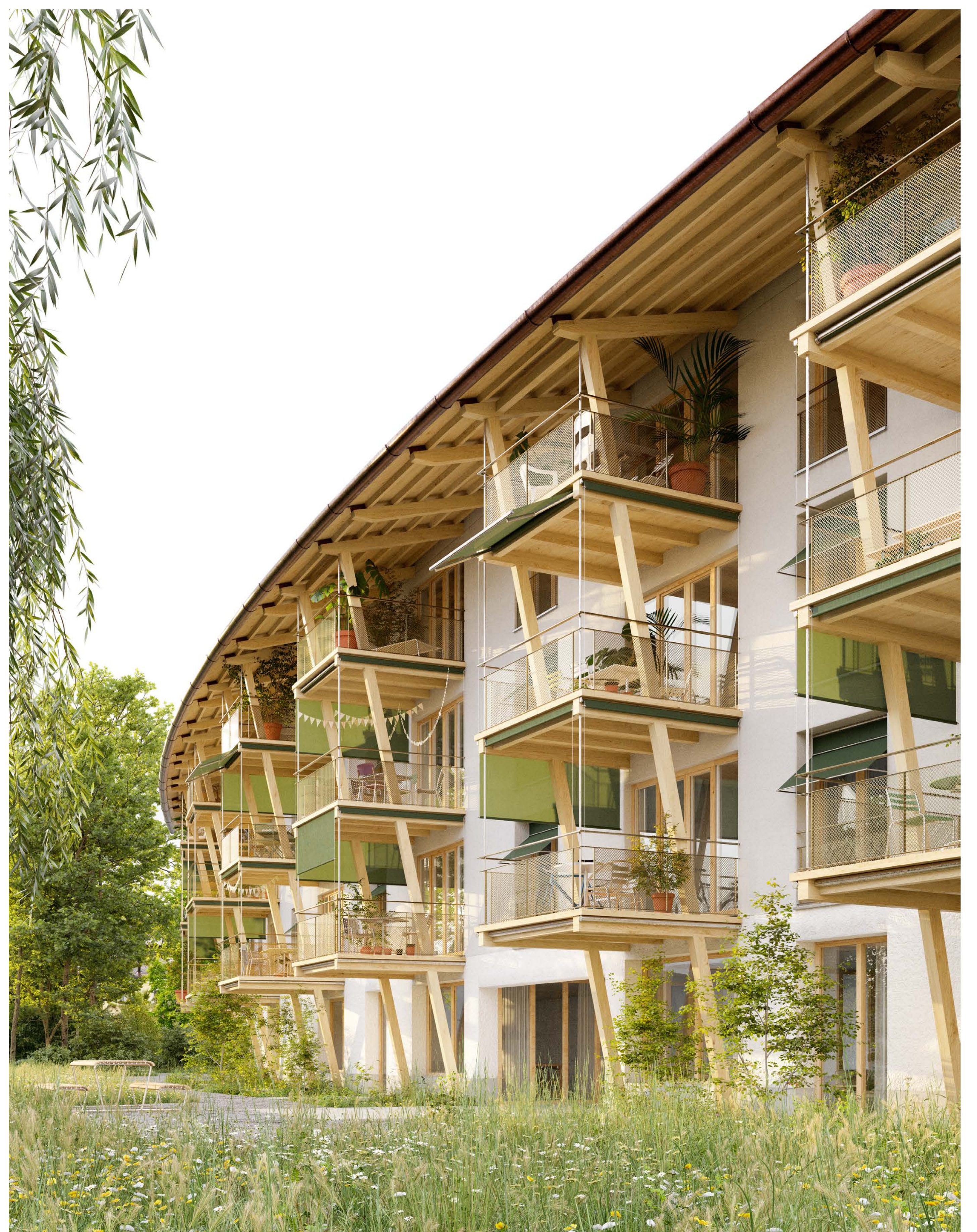
Les nouveaux balcons sont suspendus au-dessus du jardin de pluie et profitent d'un rapport privilégié avec La Versoix (b)
