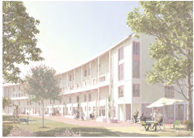
rue du-vieux-moulin et espace extérieur communautaire
