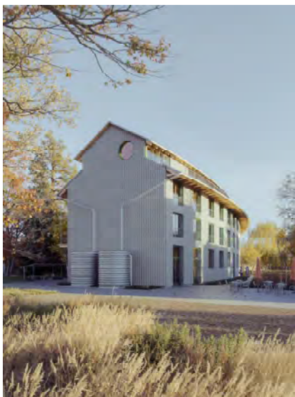
Le captage des eaux de pluie est scénographié en façade
