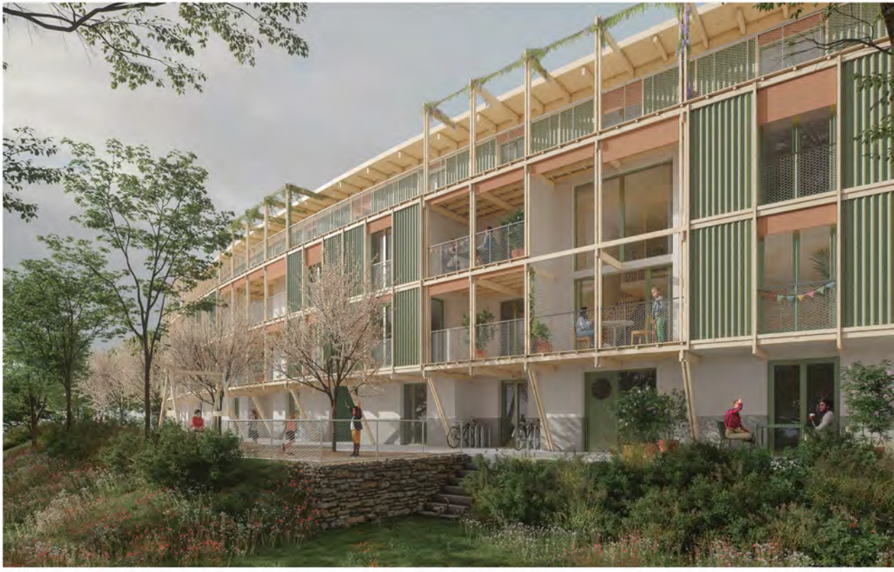
Photographie de l'extérieur du bâtiment, montrant la structure en bois et les grandes fenêtres.
