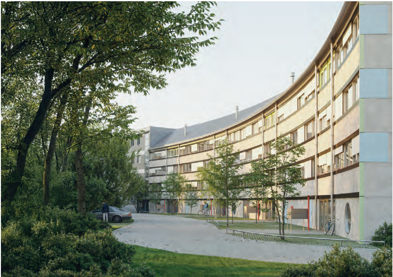
façade ouest, adressage et entrée des halls traversant
