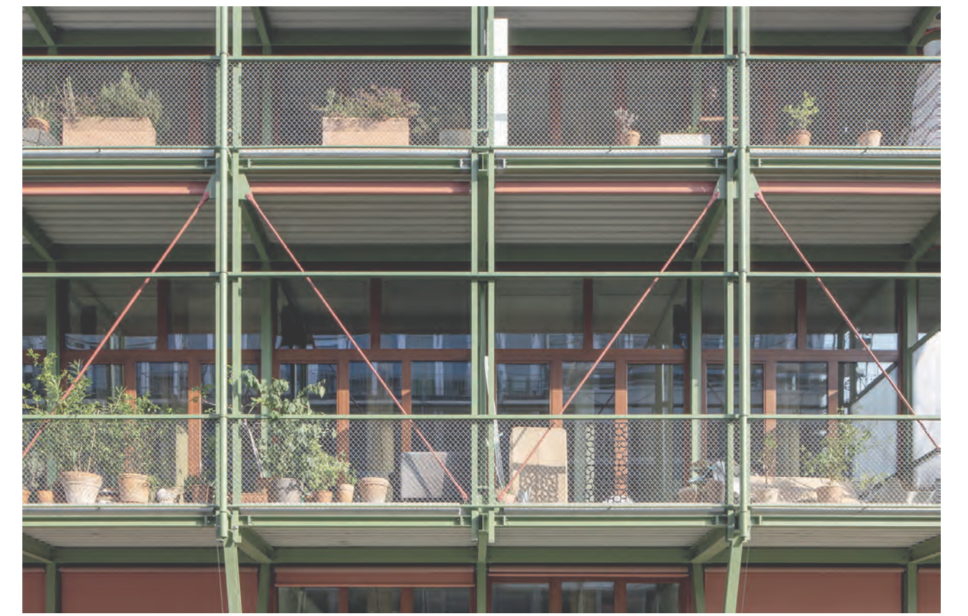
TRANSFORMATION : AJOUT DE BALCONS ESCH SINTZEL - WOHNEN IM EHEMALIGEN WEINLAGER, BASEL
