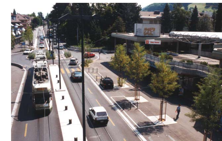
Setfingenstrasse, Künz, vorher/nachher Neuordnung des Strassenraums: kompakt & effizient, mit Mehrzweckstreifen und Velo-Infrastruktur
