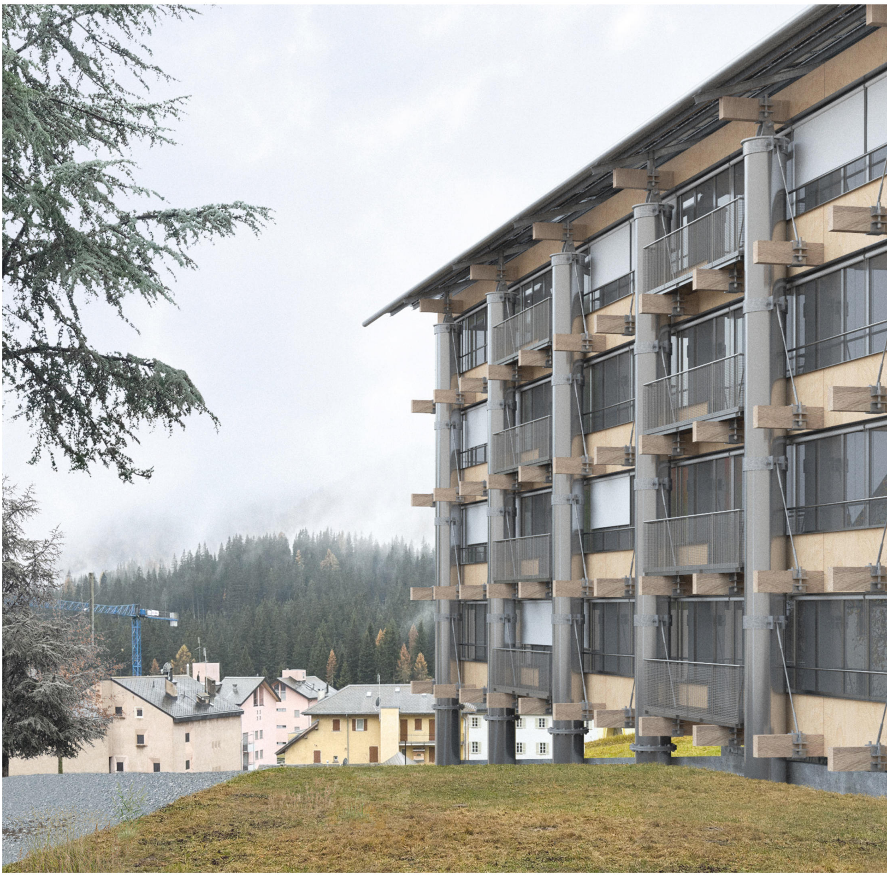
VISTA DELLA FACCIATA SUD-EST
