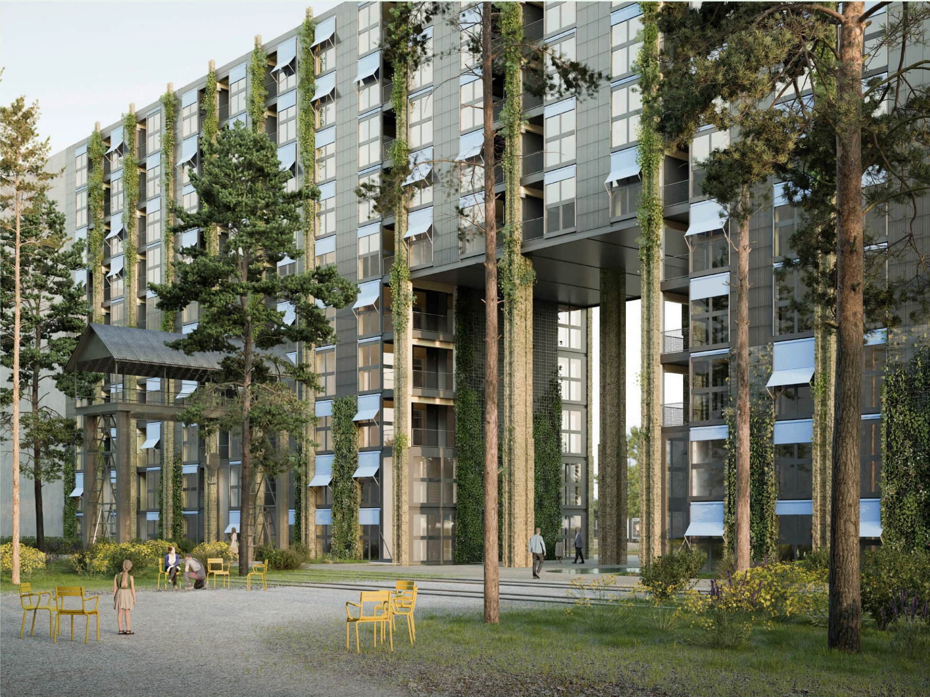
Das Haus After ALife Ahead erhält seine Identität über eine performative Fassade. Performativ sind sowohl die «anorganischen», gläsernen Partien mit Fenstern (solare Gewinne) und Photovoltaik (Stromproduktion) als auch die gliedernden, «organischen» Tuffsteinpfeiler, die als «wandelbare, lebendige Pilaster» Fassadenbegrünung und Wassermanagement verbinden.
