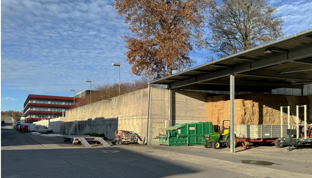
Bestehende Stützmauer und Unterstand AM
