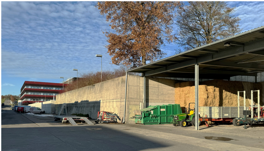
Mur de soutènement et abri existant AM
