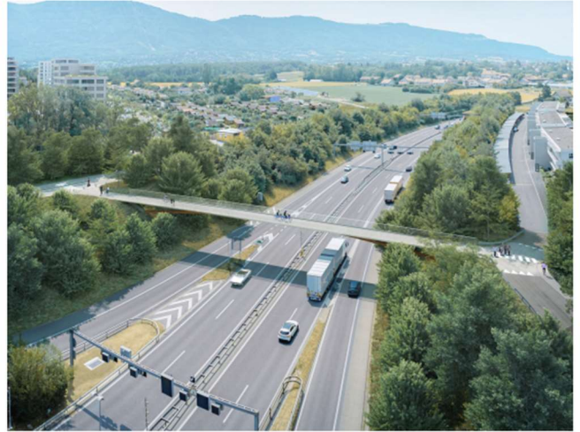
Vue aérienne au-dessus de l'A1
