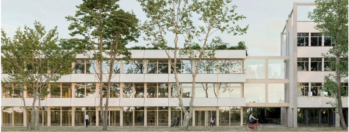
Der neue Verwaltungsbau ist ein attraktiver und identitätsstiftender Arbeitsort mit einem zeitgemässen, nachhaltigen und zukunftsweisenden Ausdruck. Praktisch, einfach und intelligent ist es eine Infrastruktur für die verschiedenen Nutzungen. Ein Haus zum Brauchen!
