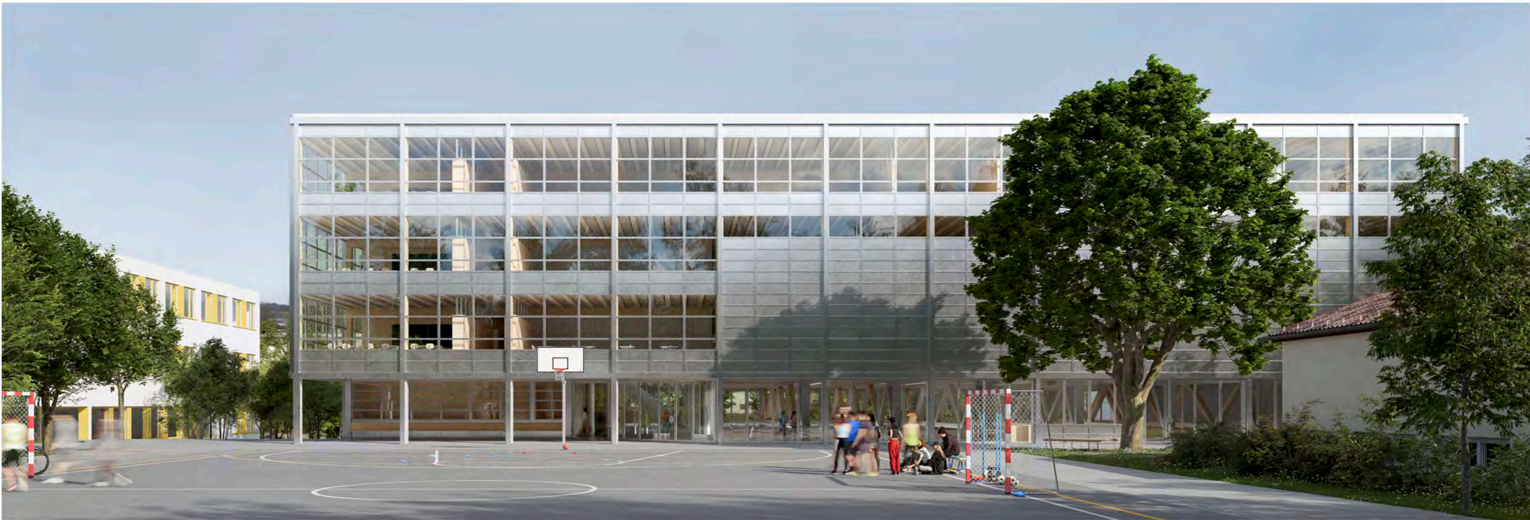
Blick über den Pausen- und Allwetterplatz zum Haupteingang
