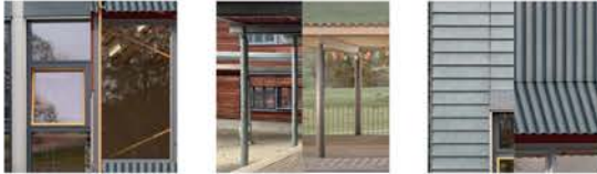
Matériaux similaires : même vocabulaire entre la nouvelle boîte et l'existant : serrures et menuiserie métallique - couvre-toit - plaques de fibrociment
