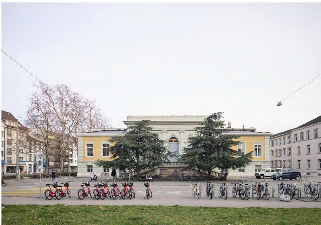
IST-ZUSTAND Bernoullianum Südfassade
