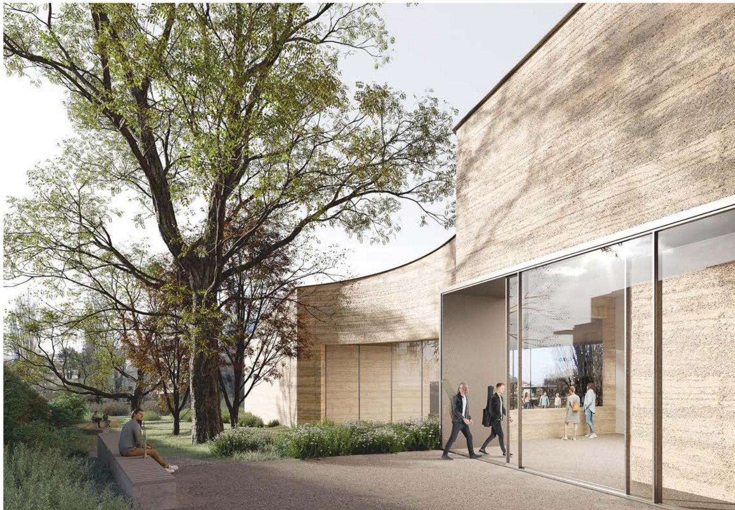
Vue sur l'entrée (nord-est)
