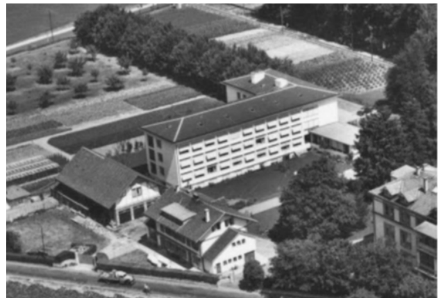
Abb. H2: Zieglerspital, in der Bildmitte der neue Ergänzungsbau, davor die Wirtschaftsgebäude Ausschnitt aus Foto von 1954
