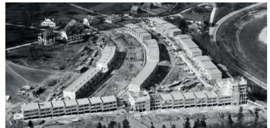
Ansicht von Süden während Erbauung 1930/31, BAZ
