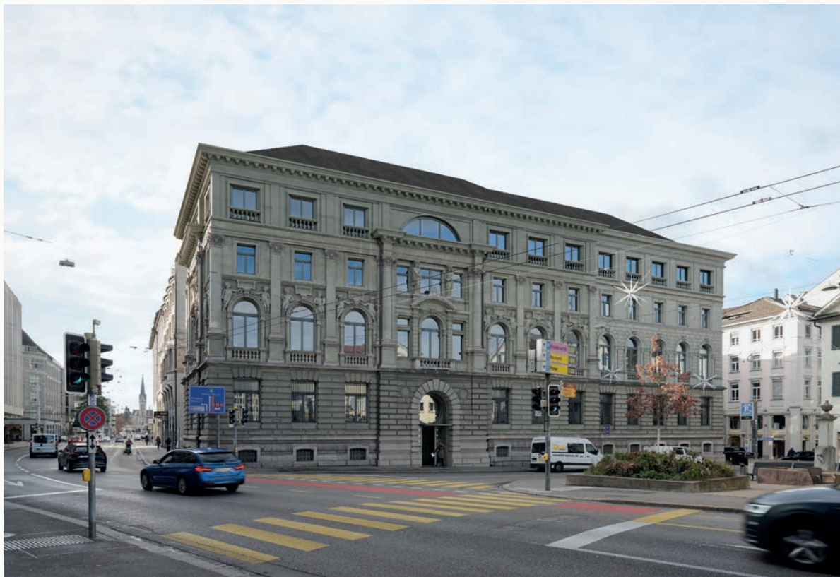
Das neue Kantongericht St. Gallen wird von den Besuchenden über den bestehenden Hauptgang betreten
