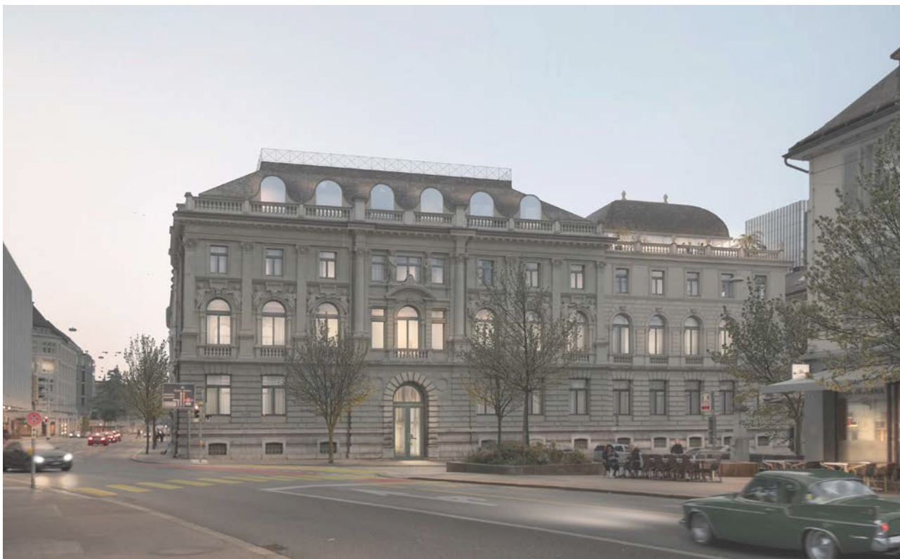
Auch Aussen wird das Gerichtsgebäude neu interpretiert und erhält eine sichtbare Struktur, die an die Geschichte des Gebäudes als erstes Bankgebäude in St. Gallen von 1884 und die nachfolgenden Erweiterungen von 1916-1918 und 1956 anknüpft.
