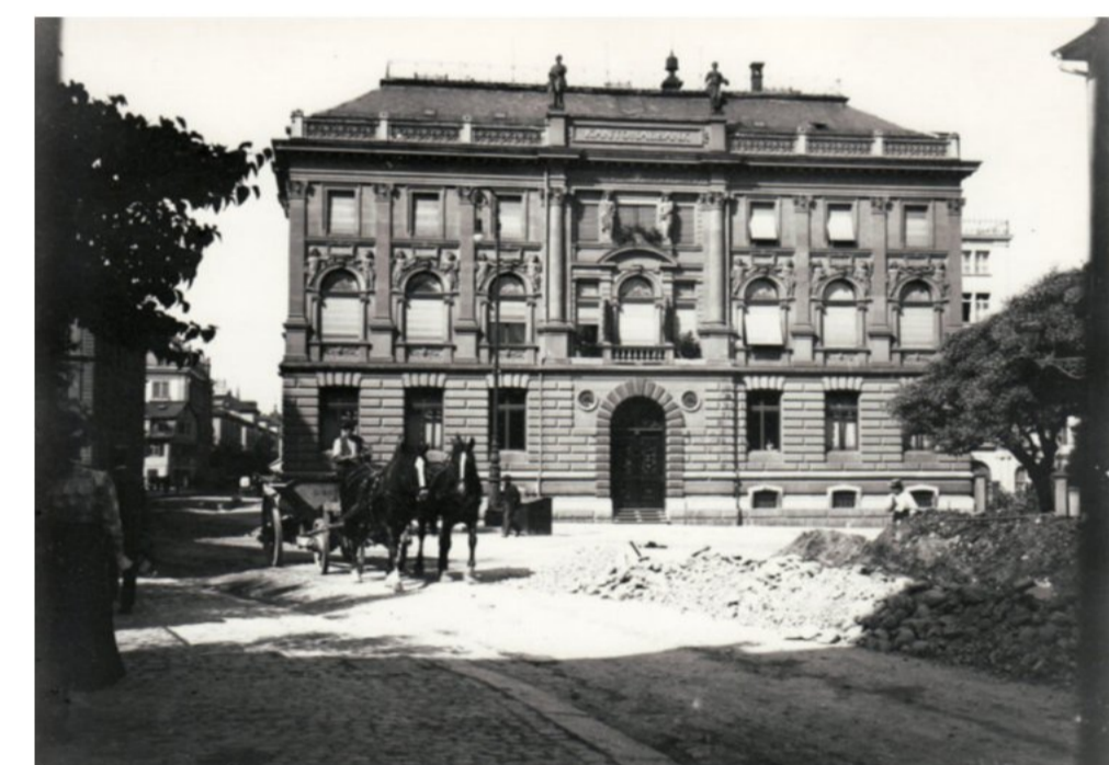
St. Galler Kantonalbank in bauzeitlicher Ansicht mit Sonnenschutz und Bogenmalereien
