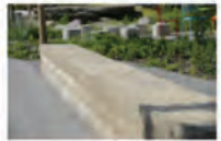
Stampfbetonmauer
