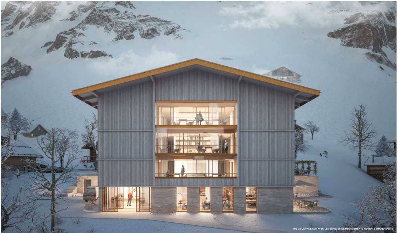
VUE DE LA FACE SUD AVEC LES ESPACES DE BÉAGEMENTS OUVERTS TRAVERSANTS
