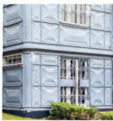
Maison de Fer, G. Biffi, Mapparo. Les modénatures classiques subissant un transfert de matérialité: le bossage des blocs de pierre devient un embossage de béton.
