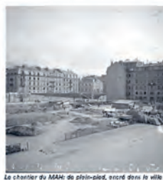
Le chantier du MAN: de plein-pied, entré dans la ville au niveau des boulevards.
