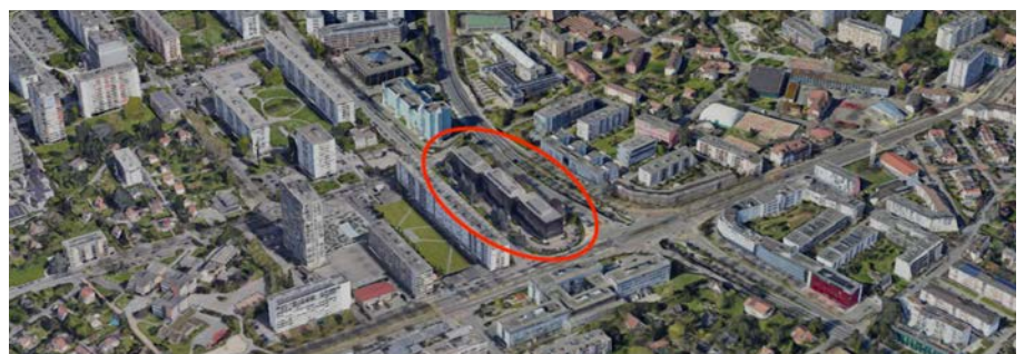
Fig. 1 : Bâtiment des Morgines 2-4-6 et son contexte
