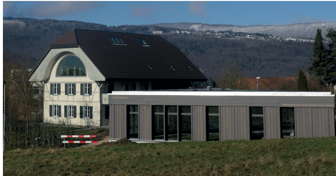
Abb. 6: Altes «Lehrerhaus» Umbau in einen Kinder- garten und Tagesschule 2011-14 Sollberger-Bögli Architekten
