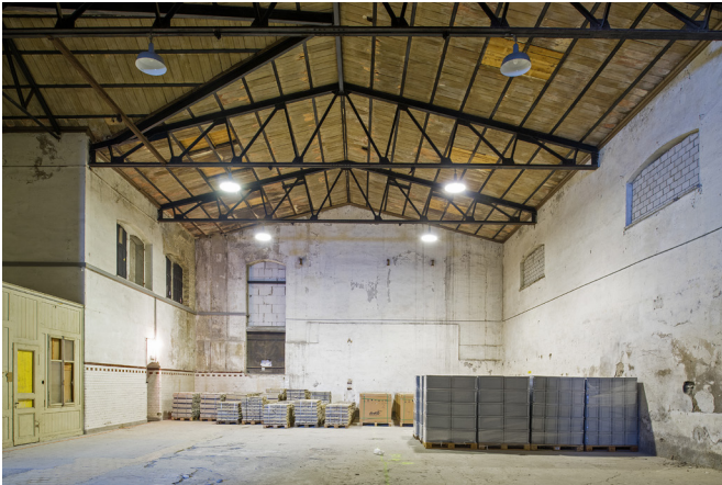
Kesselhaus; Innenraum Halle, Foto: Juliet Haller
