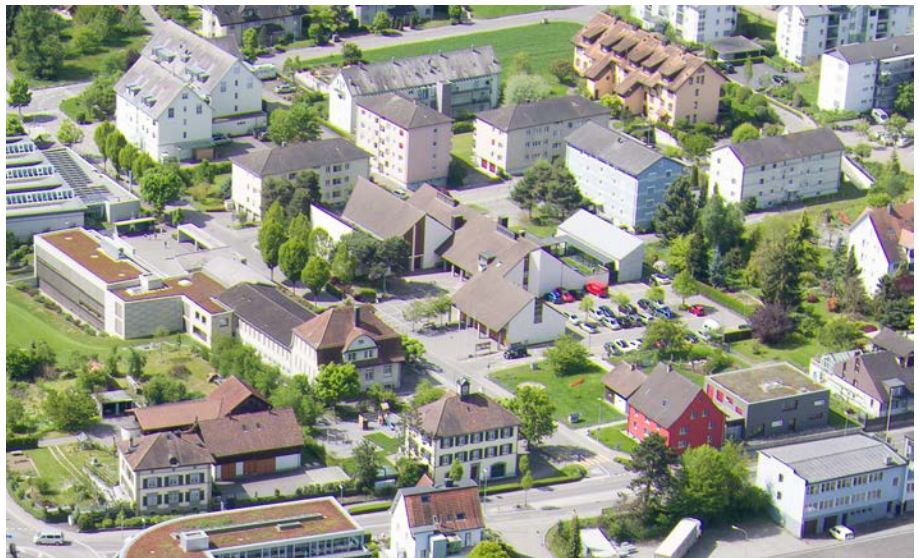
Schulareal und Gemeindezentrum (Luftaufnahme 2017 © Donald Kaden)
