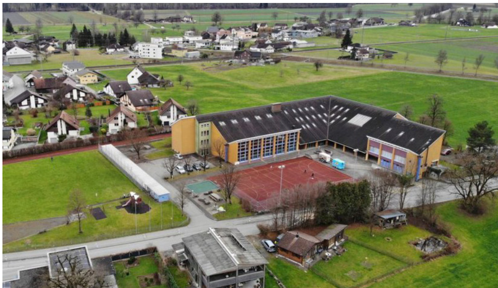
Bestehende Schulanlage Türggenau
