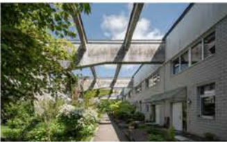
Arche Nova, Suter Suter Architekten
