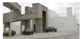
Alvaro Siza, Quinta de Malagueira, Coenrdliche Wasser- und Medienversorgung
