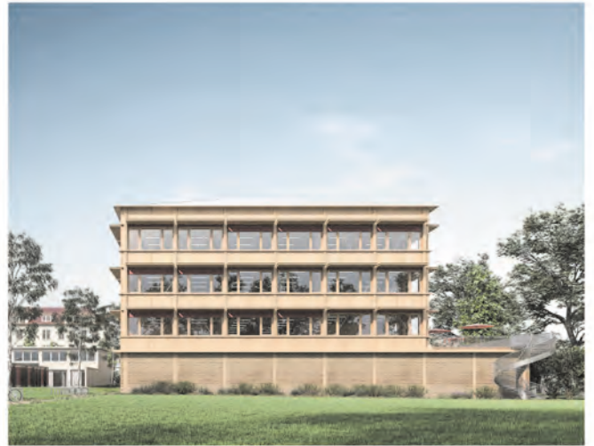
Das Piano Nobile verfügt über einen mit Freitisch abgedeckten Aussenraum in Form einer Terrasse, welche als privater Freizeitsitz sowie als Lernort dient.
