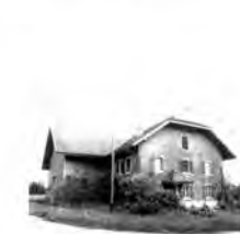
Ferme Les Bûches, Cullayes, réajustement architectural
