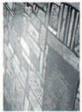
Revêtement de sol en Epiplast, composé de graviers de couleurs
