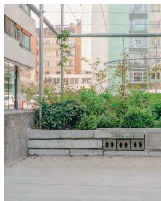
Réemploi Murs d'assise avec habitat
