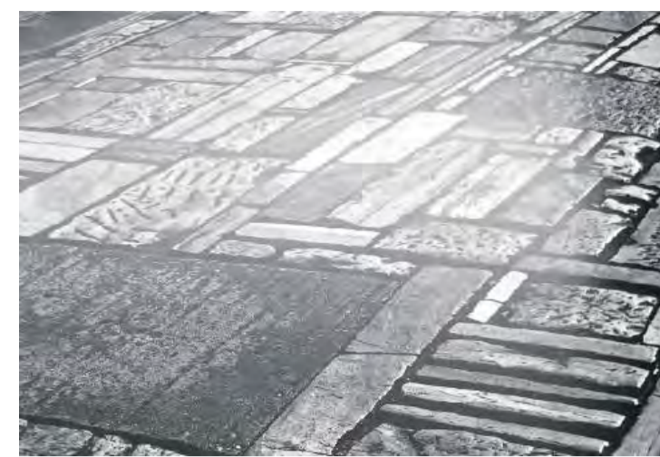
Revêtement de sol de l'esplanade; constitué de pavés de réemploi
