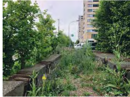
Murets - assises en béton, réemploi
