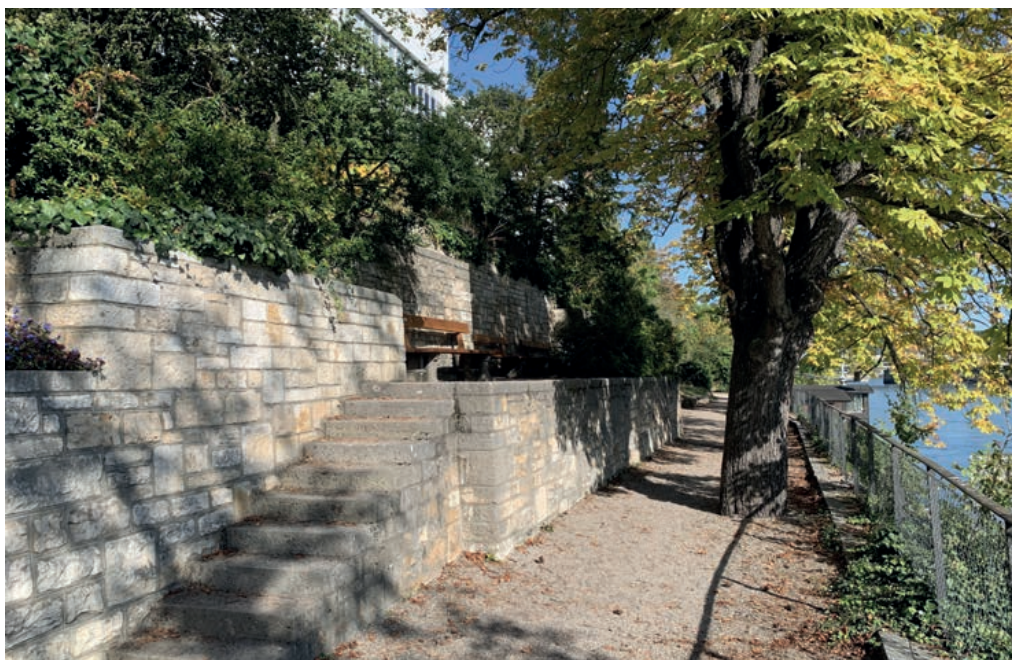
Solitude-Promenade, Bereich Mediterraner Garten, Böschungsmauern
