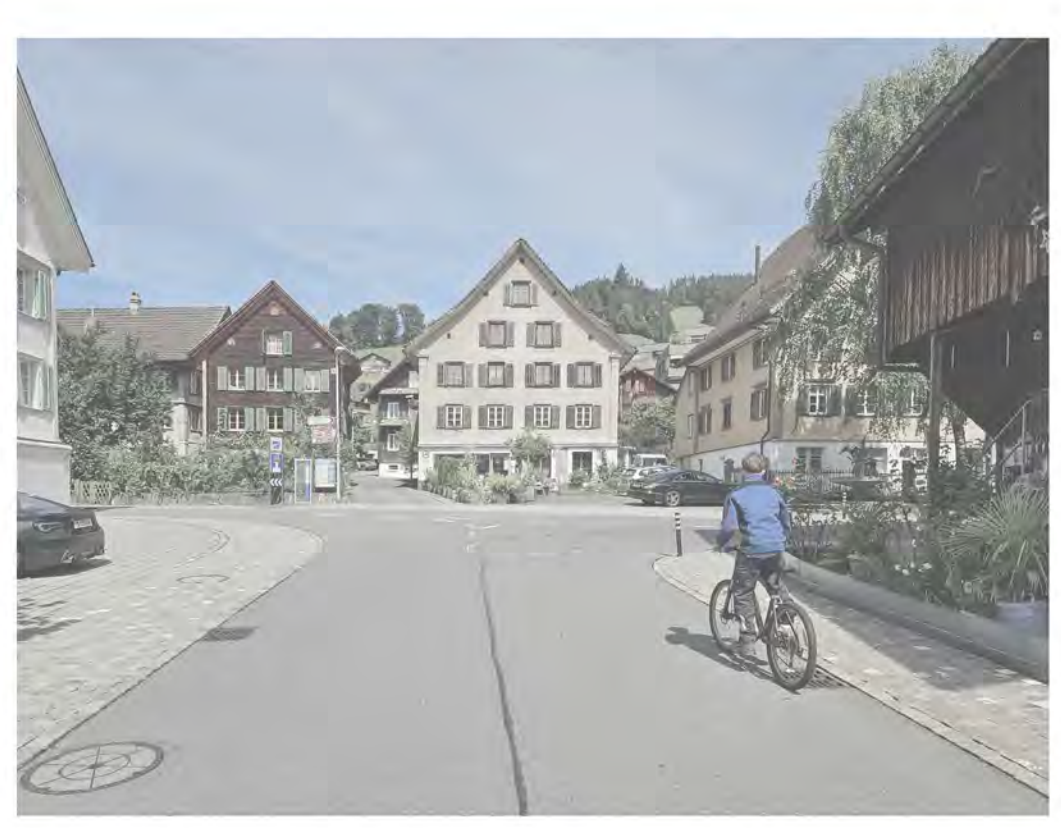
Oberdorfstrasse und Kerngebiet Oberdorf
