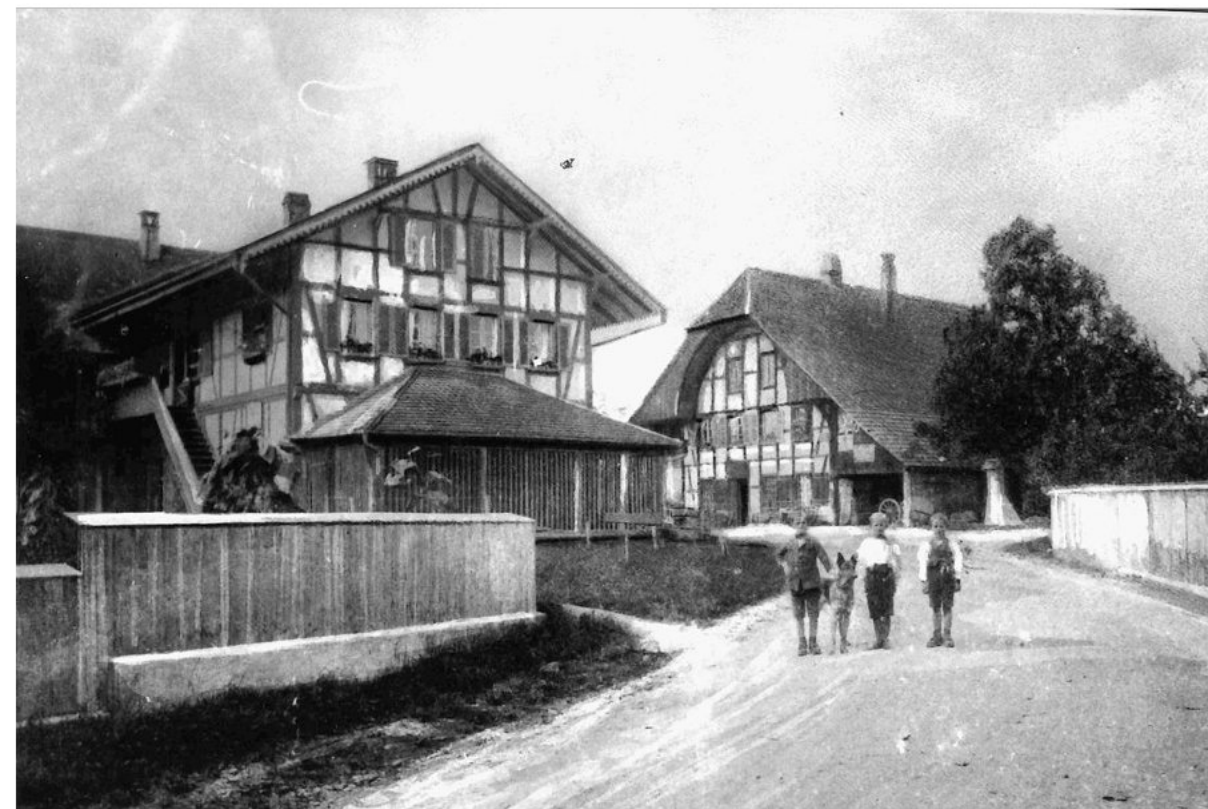
Blick von Südosten auf die Ostfassade des Käseriegebäudes. Retouchierte Fotografie Ernst Schlotter [?], Archiv KDP, um 1900. Um 1883 entsteht der zunächst als Käseriegebäude genutzte Gebäudeteil gegen Süden. Ein zeitlicher Riegbau unter Satteldach mit profilierten Balkenvorstössen und Bügen. Gesägte Hügelnägel zieren die Dachkanten.
