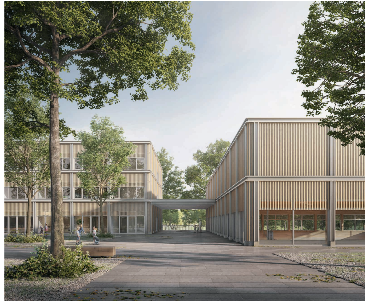
Der Pausenhof mit dem neuen Durchgang
