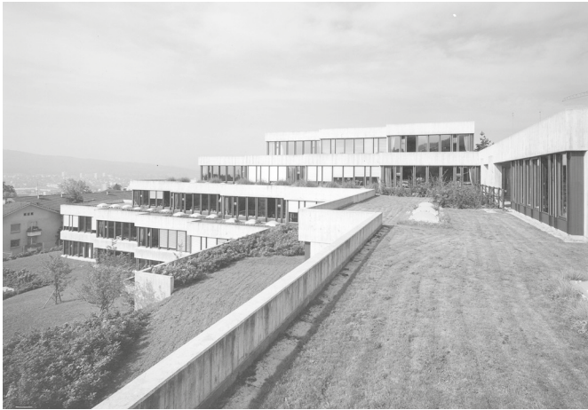
Dächer als begehbare Aussenflächen, undatiert, Baugeschichtliches Archiv, Zürich
