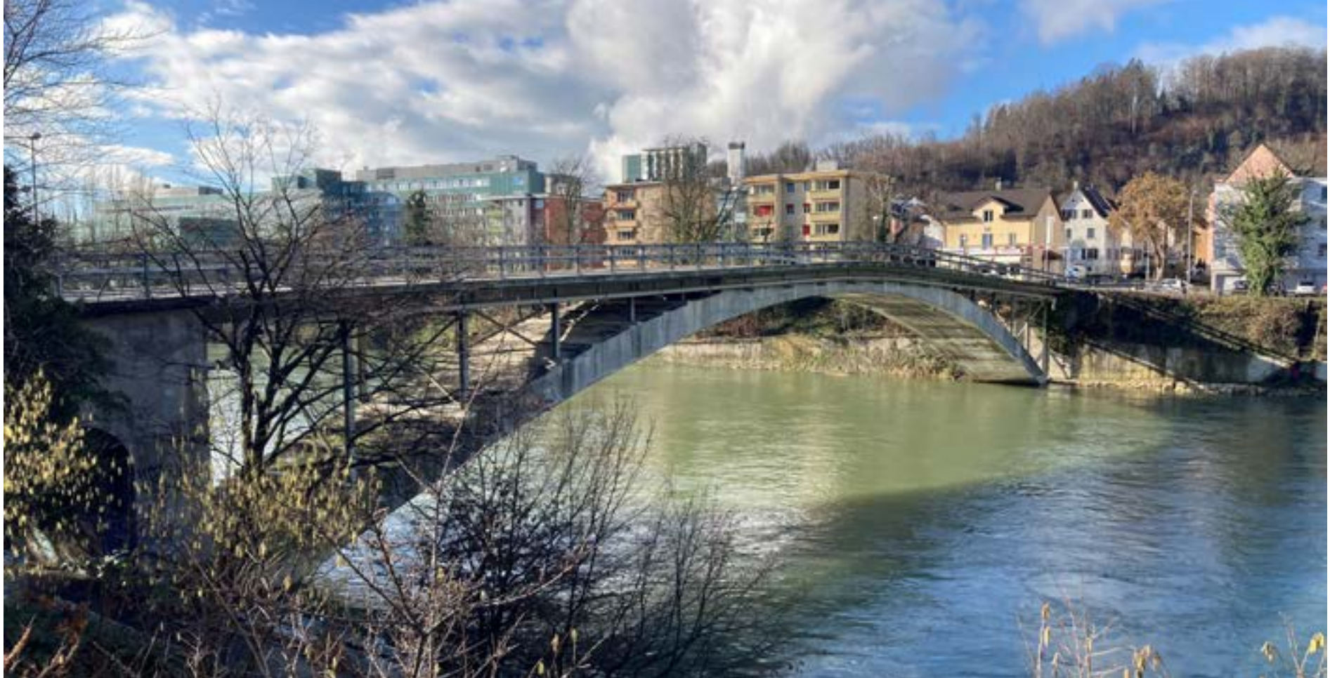
Bestehende Trimbacherbrücke (Blickrichtung Süden).
