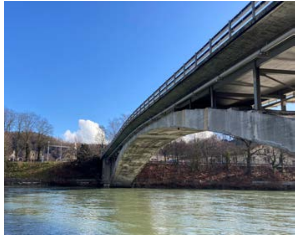
Trimbacherbrücke mit originalem Bogen von 1912/1913. Die aufgeständerte Fahrbahnplatte stammt von 2004.
