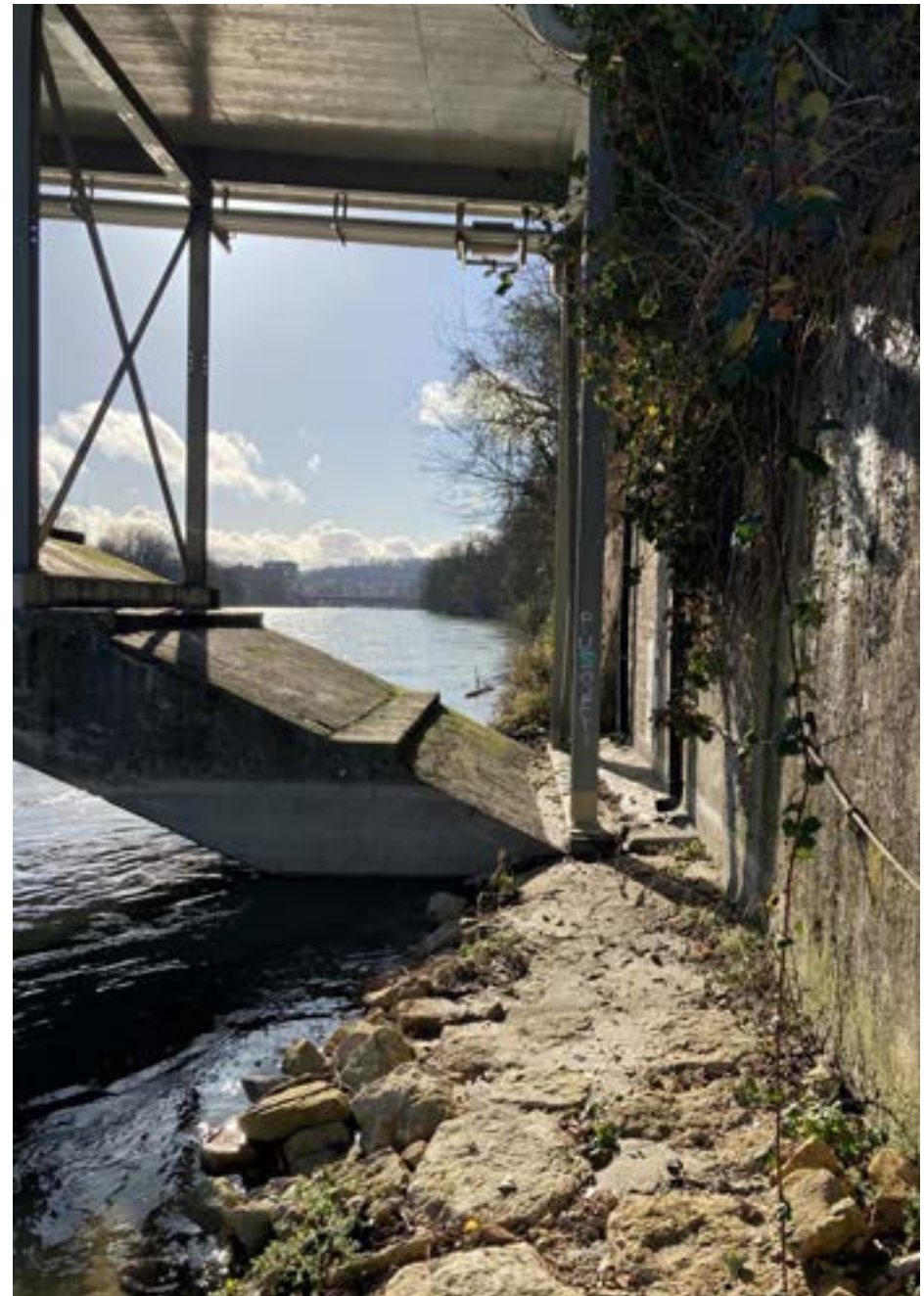
Kämpfer der bestehenden Bogenbrücke.
