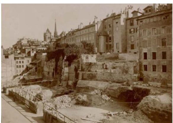
Démolition de l'île Rôtisserie et remise à nu des murs de soutènement, 1916
