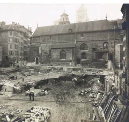
Démolition de bâtiments et remblais au pied du temple de la Madeleine, 1927
