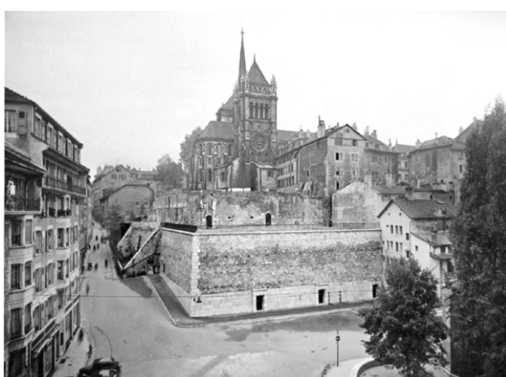
Construction de l'abri anti-aérien et de la terrasse Agrippa d'Aubigné sous le soutènement de la terrasse de la Cathédrale St Pierre, 1941
