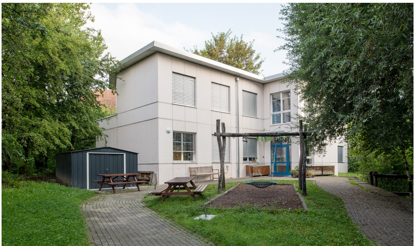
Abb. 8 Provisorium Ge- bäude G mit Ver- pfl egung und Be- treuung
