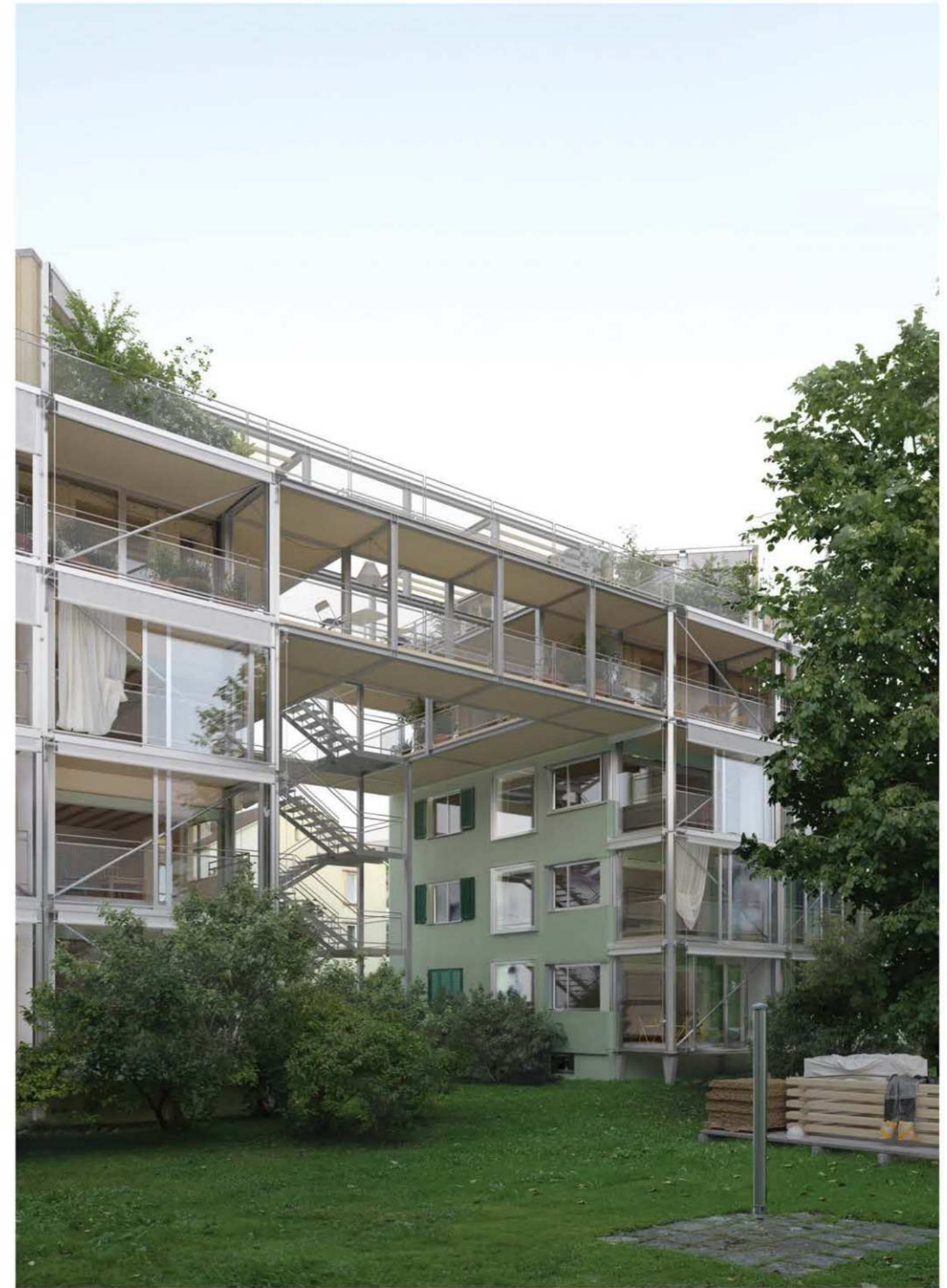
Vielleicht ist der Umbau in Phase I gerade abgeschlossen, und die neue Baustelle steht kurz vor dem Start, aber die ersten Bewohner bewohnen bereits ihre Wohnungen und Wintergärten zum Garten hin.
