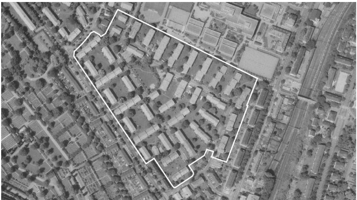
Abb. 1 - Luftaufnahme der Stammsiedlung aus dem Jahr 1981 (Quelle Luftbild: GIS-ZH, 2022)
