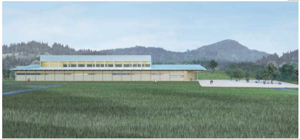
Vue de l'intégration de la salle de sports dans le paysage environnant
