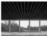
Vue intérieure regardant vers l'extérieur, détail de la façade
