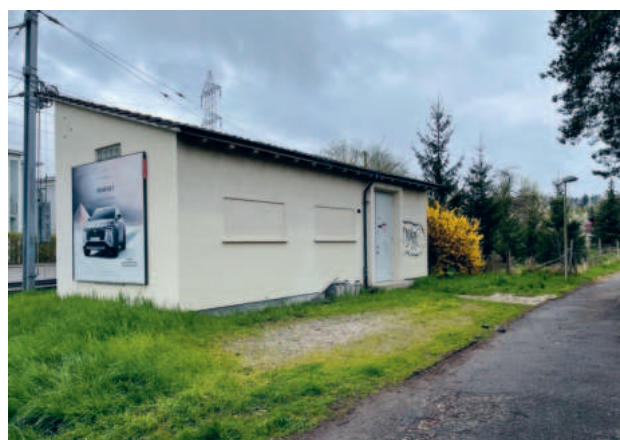
Zwingenstrasse und Trafostation
