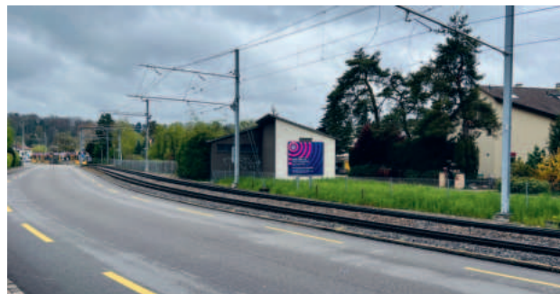
Emil Frey-Strasse mit Tramlinie und Trafostation
