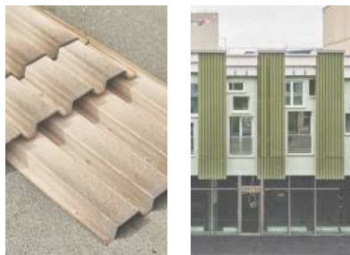
Exemple de réemploi de tuile à Bâle pour le bâtiment ELYS (2021) Architectes : BAUBÜRO IN SITU
